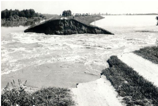
Figure 4. Breach at the Kettős-Körös in 1980.
