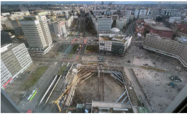
Figure 6. The construction site ( https://www.rbb24.de/panorama/beitrag/2023/02/u2-covivio-alexanderplatz-beton-lanzen-tunnel-baugrube.html )
