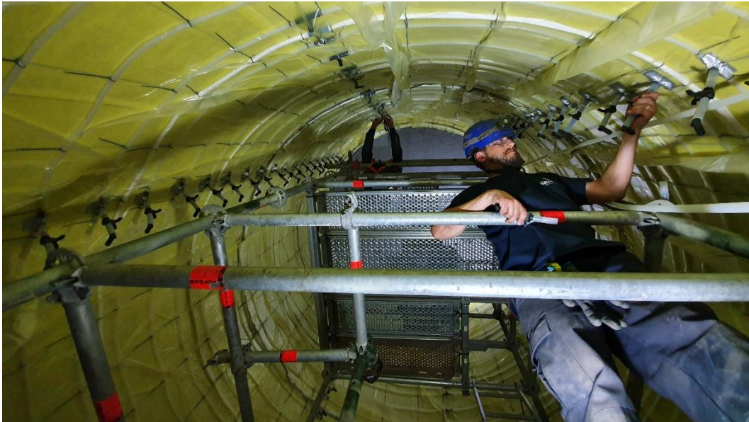
Figura 11. Reacondicionamiento interior de depósitos con dificultad de desmantelamiento.
