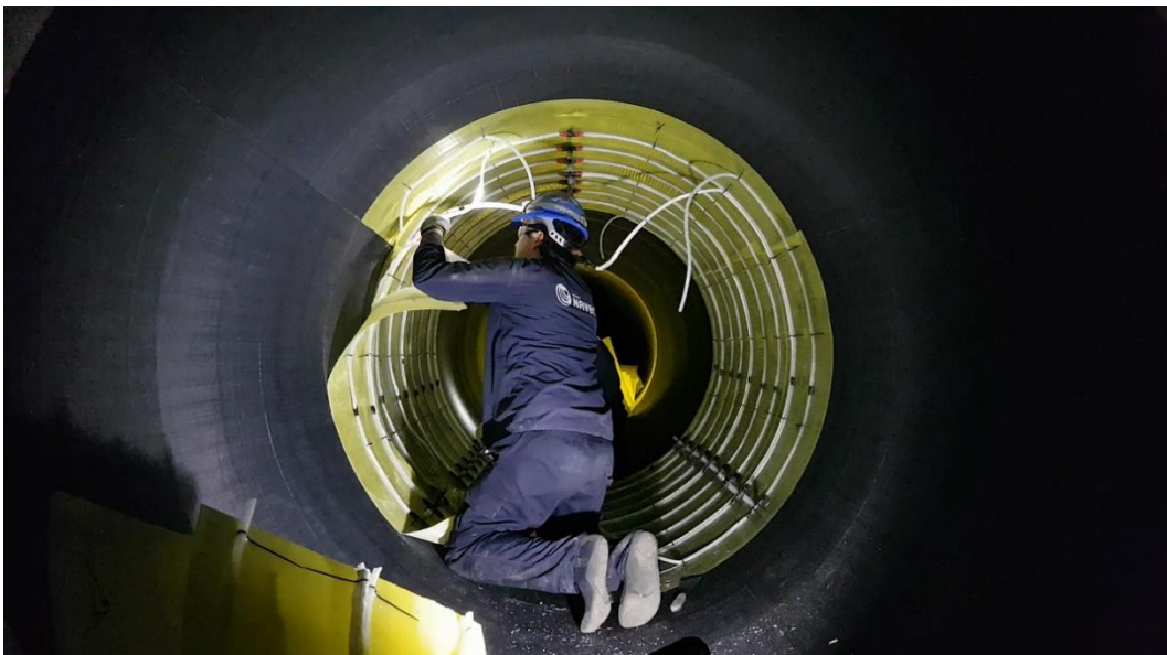
Figura 8. Conjunto resultante de fibra de carbono y matriz epoxi una vez retirado el sistema.
