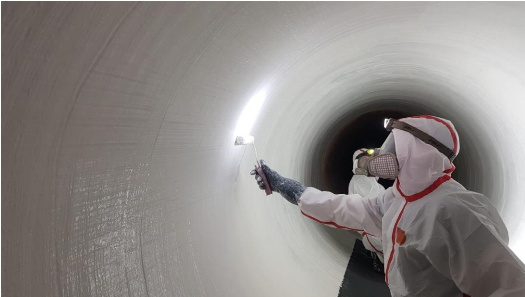
Figura 9. Revestimiento de protección de la nueva conducción de fibra de carbono.
