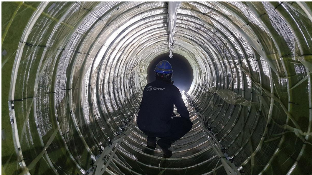
Figura 1. Sistema de infusión y vacío en tubería de distribución de agua potable DN 1600 mm.
