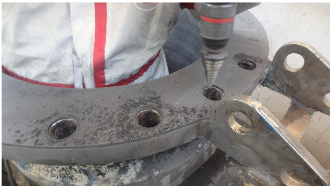
Figura 10. Reacondicionamiento de bridas y bocas de hombre de fundición gris.
