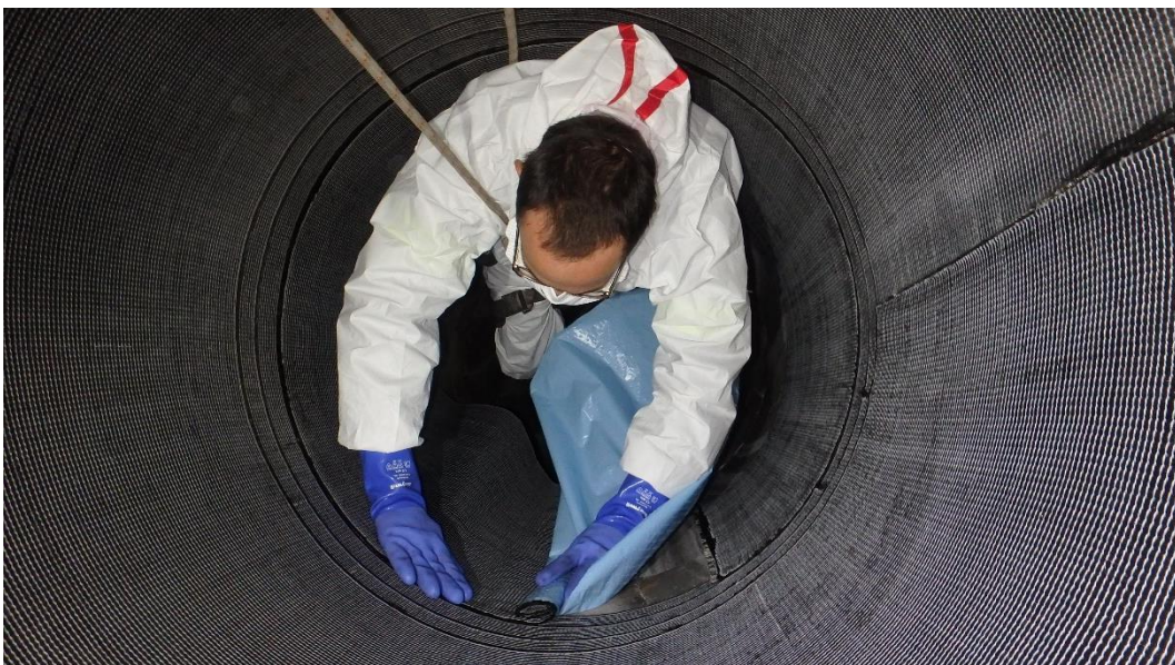
Figura 3. Diseño de colocación de fibra de carbono continua en tramos verticales o inclinados.
