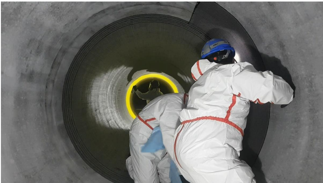
Figura 2. Diseño de colocación de fibra de carbono continua en tramos horizontales.
