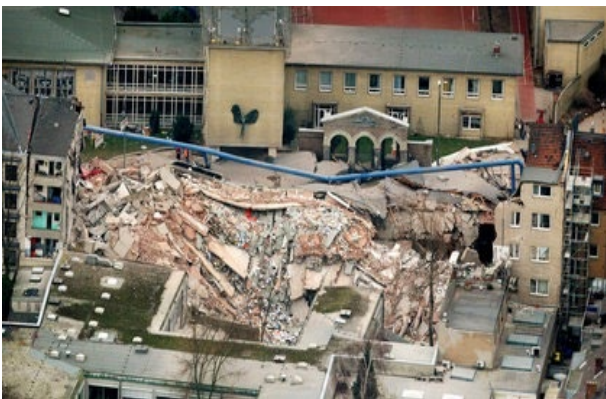
Figure 3. Collapse of the archive building in Cologne ( https://www1.wdr.de/radio/wdr5/sendungen/morgenecho/stadtarchiv-112 )
